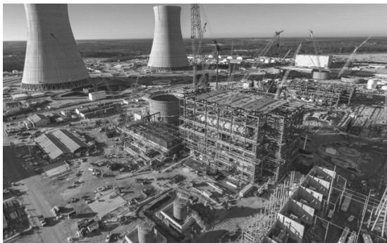
Vogtle 원전 건설 현장
