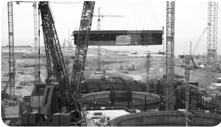
신고리 5호기 원자로건물에 지상에서 따로 조립한 격납철판(CLP·Containment Liner Plate)이 설치되었다.
