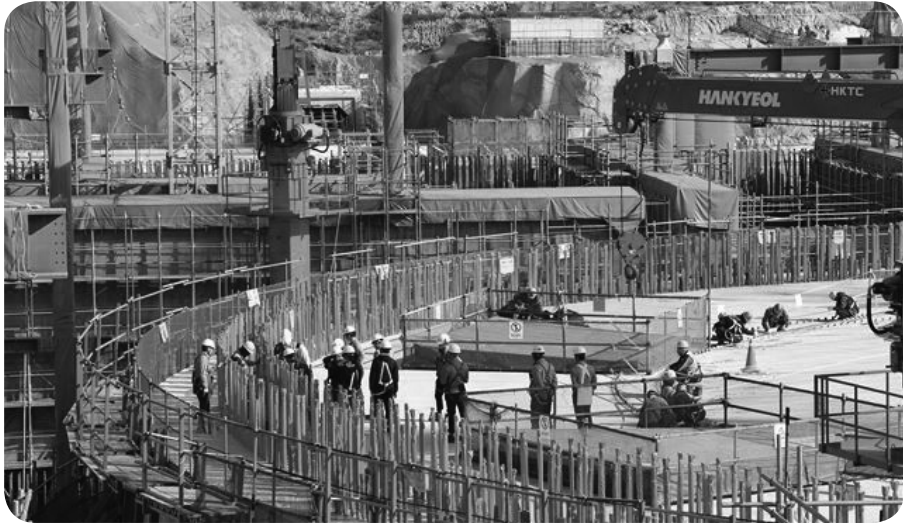
신고리 5.6호기 건설 현장. 2017년 10월 공론화를 통한 사회적 합의를 거쳐 건설 재개가 결정된 신고리 5.6호는 2018년 1월 현재 분관 구조물 신축 공사와 수중 취·배수 시설 공사가 진행되고 있으며, 2022년 3월, 2023년 3월에 각각 준공될 예정이다.
