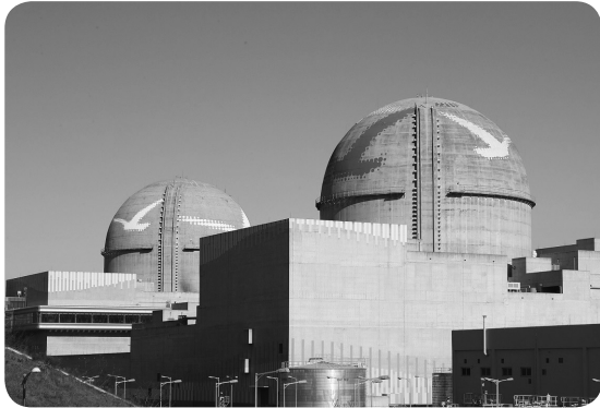
신고리 3호기(뒤는 신고리 4호기). 신고리 3호기는 2016년 12월 준공 이후 389일 동안 단 한 번의 정지 없이 안전 운전을 달성하고 2018년 1월 12일 첫 계획예방정비에 착수하였다.
