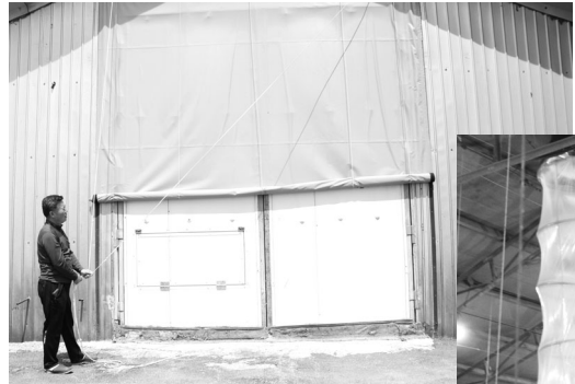
▲ 닭의 스트레스 최소화와 건강관리를 위해 개발한 외부 바람을 최소화하기 위한 바람막이(위), 환기시스템 '자바라'(오른쪽)
