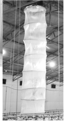
▲ 닭의 스트레스 최소화와 건강관리를 위해 개발한 외부 바람을 최소화하기 위한 바람막이(위), 환기시스템 '자바라'(오른쪽)
