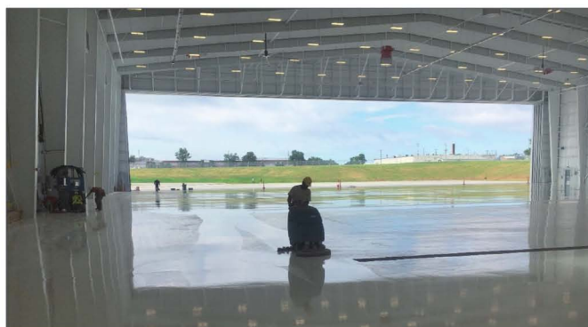
격납고 프로젝트 공사 현장
