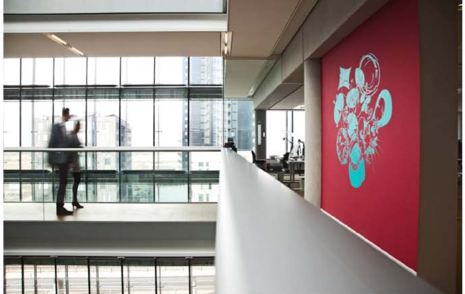
그림 8) 파사드와 콘크리트 디테일
