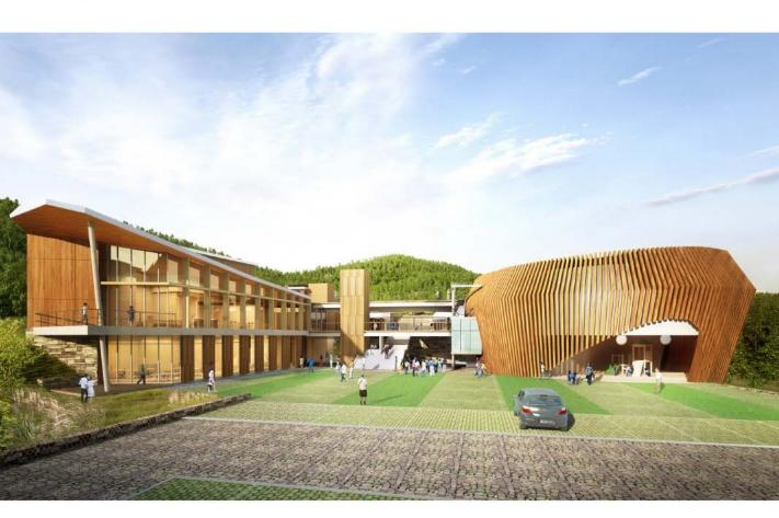
건축주 | 대전광역시 / 설계팀 | 백유미, 이승환, 김희수 / 대지위치 | 대전광역시 유성구 성북동 산 1-13 일원 / 주요용도 | 자연휴양림 / 대지면적 | 9,989,79㎡ / 건축면적 | 1,744.11㎡ / 연면적 | 2,996.95㎡ / 건폐율 | 0.53% / 용적률 | 0.41% / 규모 | 지하 1층 ~ 지상 2층 / 구조 | 중량목구조, 경량목구조, 철근콘크리트조 / 외부마감재 | 목재루버, 집성목판재, 노출콘크리트, 칼라로이유리 / 설계기간 | 2016, 02 ~ 2016, 03
