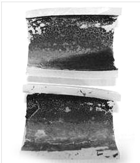
▲ 농장의 오염된 배관(백신 바이러스가 배관 내 각종 유기물에 대다수 흡착된다)
