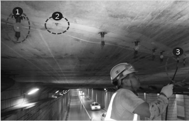
1. 스마트 밸브, 라텍스 탄성저장관, T-Port 및 Pin-Port
