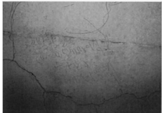
**Fig. 4** Longitudinal Crack
