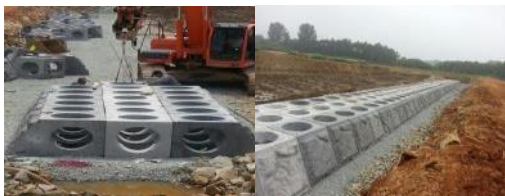
Fig. 1. Site test construction
