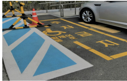
그림 3. 시설물로 인한 위험상황 Fig. 3 Risk situation due to facilities
