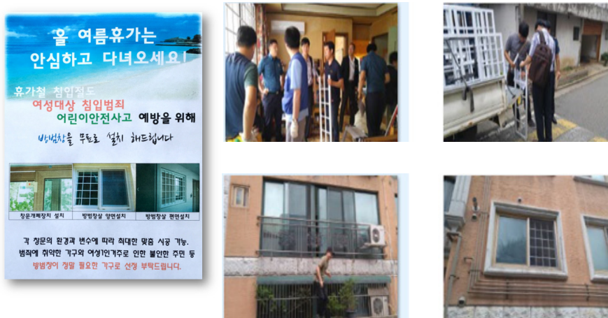
〈그림 2〉 방범인증시설 설치 홍보문과 설치 장면
