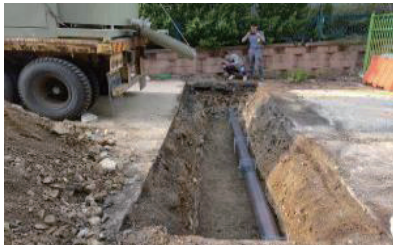
(4) 관 매설 및 채움재 타설
