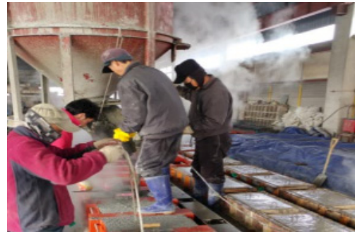
(d) Concrete pouring
