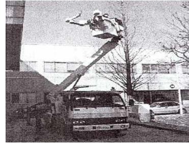
그림 22 양팔형 활선로봇 동작모습 Fig. 22 Operating figure of dual-arm live-line robot
