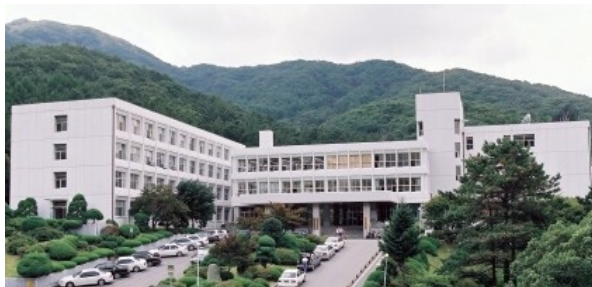
리모델링 전 전경사진
