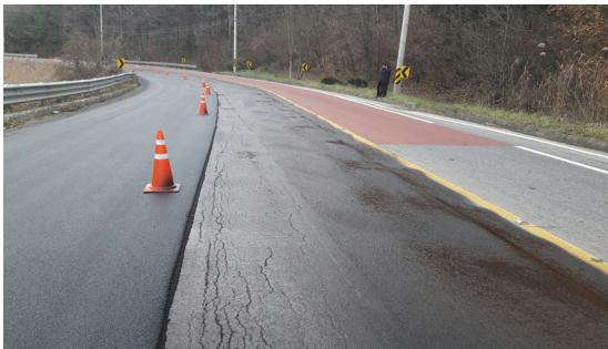
(b) 개질 유화아스팔트 도포 모습
