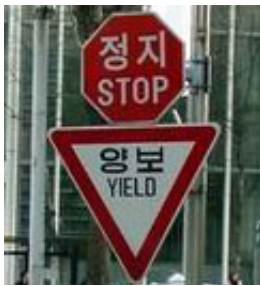
그림 2. 서로 다른 내용의 규제가 하나의 지점에 설치된 현장 안전시설 기능관리 실패 사례 (서울시 역삼동)
