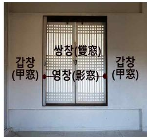
그림 12. 횡장자가 설치되지 않은 낙선재의 이중창호
