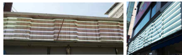
그림 3 내조형 광고조명 내부 구조 Fig. 3 Internal structure of internally emitting type
