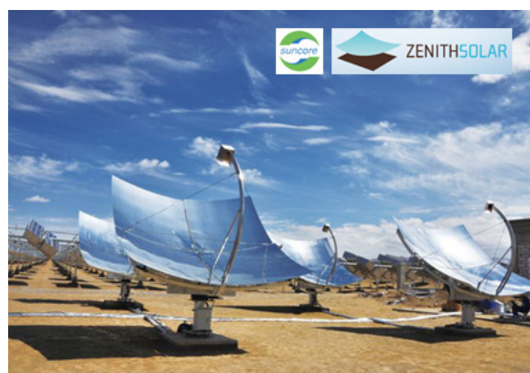
그림 2. 프레넬 렌즈 방식(좌)과 반사형 미러 방식(우)의 CPV 시스템 설치 사례 [12,13]
