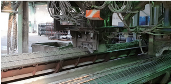
(c) 복합슬래그잔골재 혼입 콘크리트의 생산 및 타설
