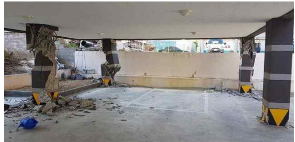
그림 1. 포항지진으로 파괴된 필로티 구조 Figure 1. Damaged Piloti Structure after Pohang Earthquake. From: http://www.hani.co.kr/arti/society/society_general/819620.html
