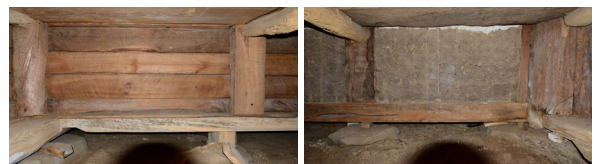
(d) View of foundation and foundation stone
