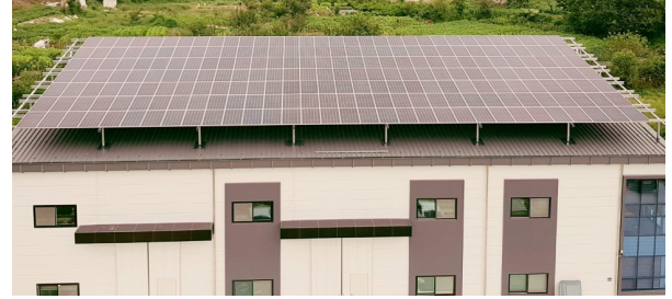
그림 4 50 kW 태양광 패널 설치 Fig. 4 50 kW solar panel installation
