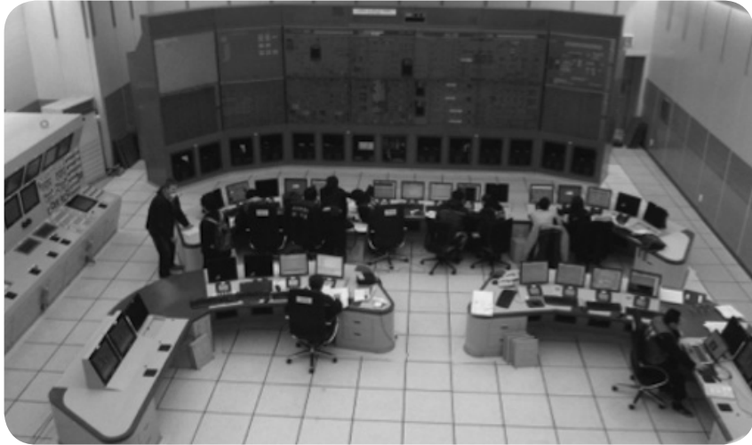
신고리 3호기 주제어실의 개인별 워크스테이션 배치. 원자로 담당자, 터빈 담당자, 전기 담당자, 작업 조별 관리자 및 교대 발전 책임자의 콘솔(console)들이 배치되어 있다.
