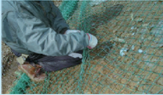
능형망 설치 작업
