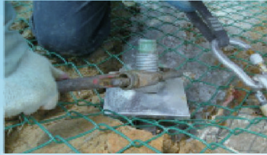
지압판 설치 및 스마트체크홀 기능 확인
