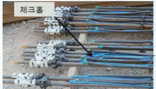
마킹 작업네일 조립 및 삽입
