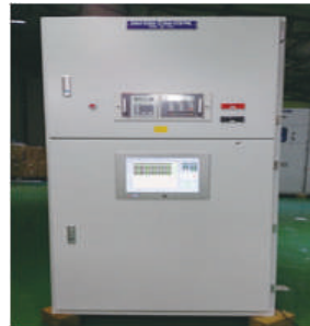
이상진단 모니터 및 계전기 설치도체접속부 풀림부분 완전 조임
