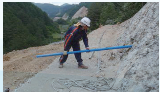
수평원형 배수관(천공, 설치) 작업
