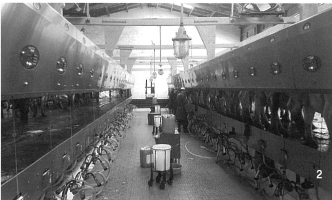
1, 2 미국과 중국 착유실에 설치된 2열 40두 보우메틱 착유기
