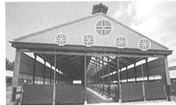
용마루 환기 및 측벽 상부 환기팬 설치
