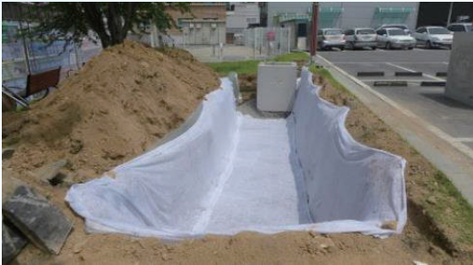
세굴방지용 부직포 설치
