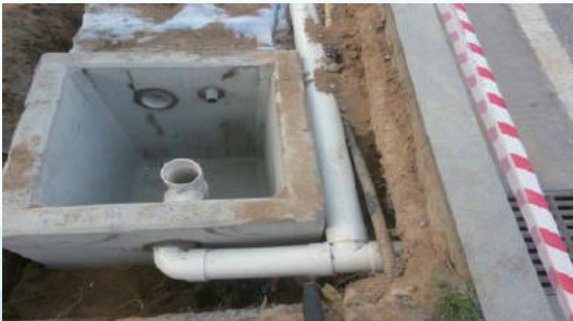
시설물간의 연결 및 배관공사
