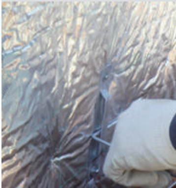
연결브라켓 및 이음절곡구 설치
