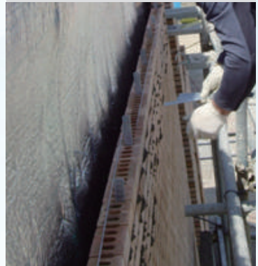
양생 전 수직브라켓 설치
