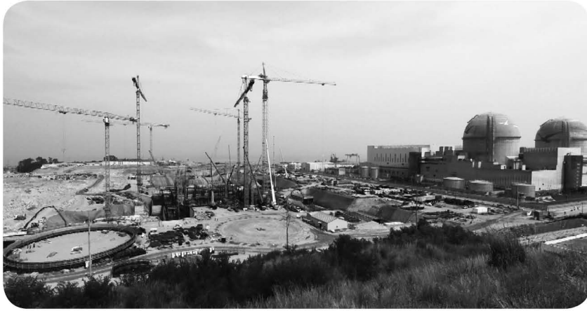
신고리 5·6호기 건설 현장
