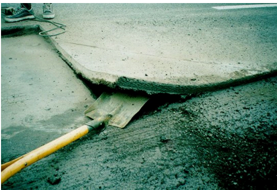
그림 1(b). 경계층 문제로 인한 교면포장 문제
