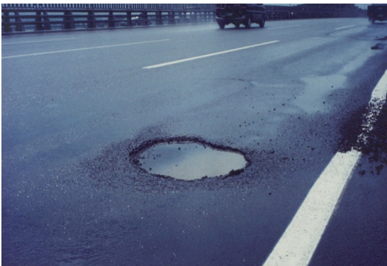
그림 1(a). 물로 인한 포트홀 발생
