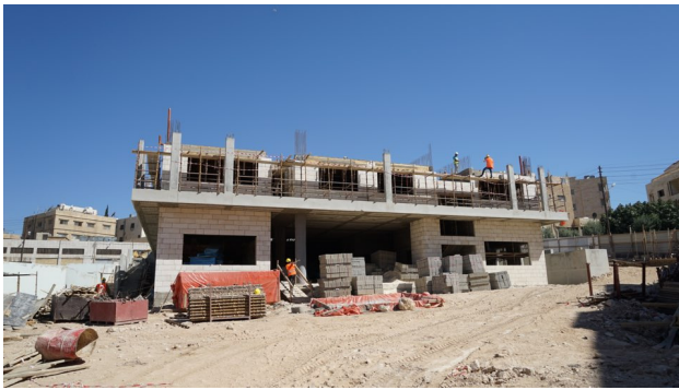
<지하층과 1층 공사진행 중임, 가설을 매우 잘함>
