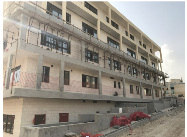
<외부 공사중 광경>
