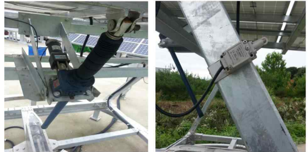
Fig. 4. Actuator in the solar tracking system 그림 4. 태양광 트래커의 모터 구동 액추에이터
