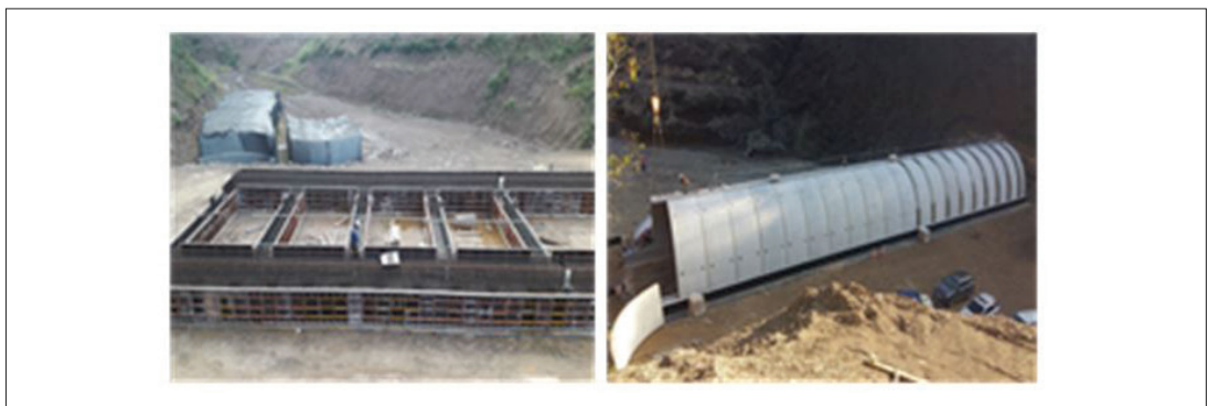
[그림9] 인버트 보강 및 출강4교 시공 전경
