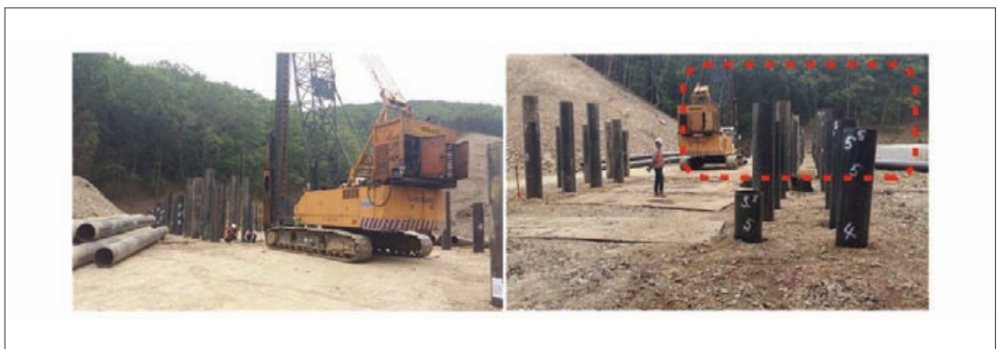
[그림4] 말뚝시공 전경
