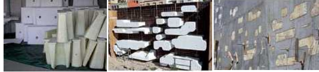
<그림 8> TEA의 도서관 내·외부의 표피와 콘크리트 구축현장
