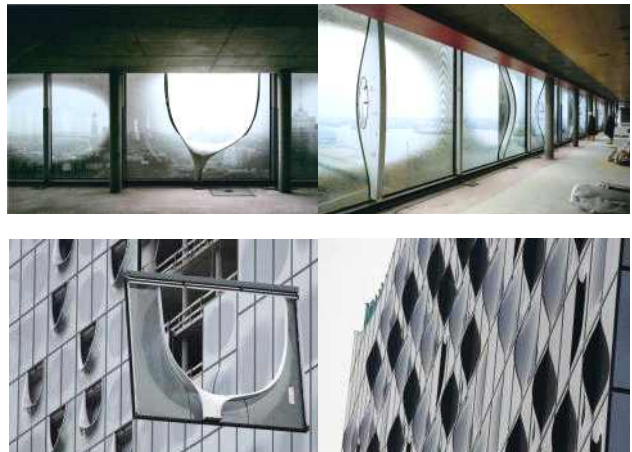
<그림 19> Elbphilharmonie의 Bent-glass 내부와 외부 시공모습
