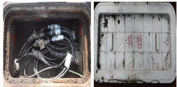
그림 6 저압 철재 지중함 내부 및 절연 고무판
