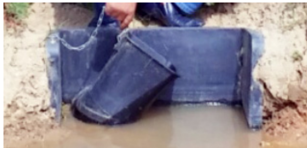
(b) 배수물꼬 설치 전경
