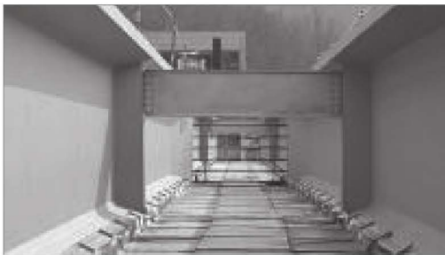
[그림 6] 당 현장 강가로보 시공 현황
