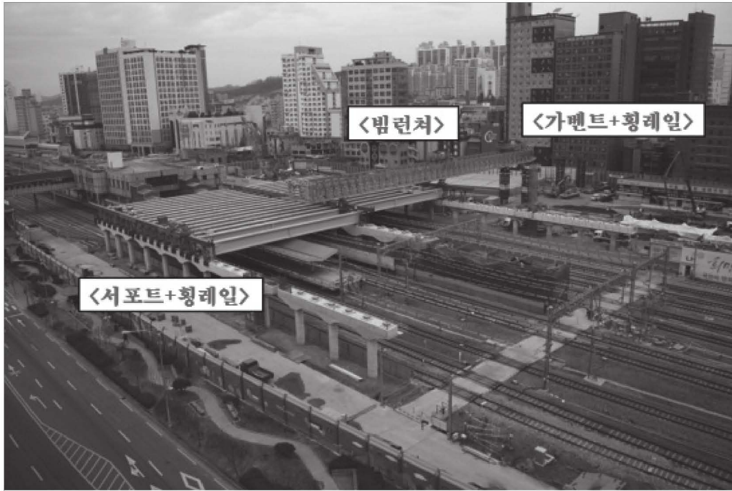
[그림 9] 인공데크 거더 런칭시스템 현황
