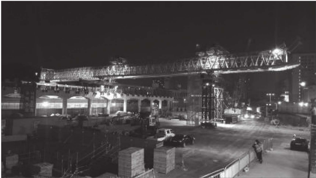
[그림 10] 빙런처 시공 전경(야간작업)
