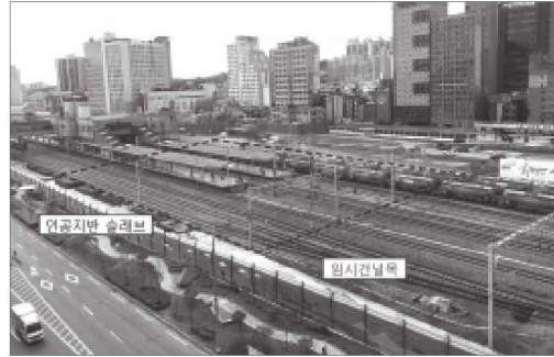
[그림 2] 인공지반 설치 부지
