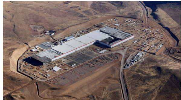
그림 7. 건설 중인 테슬라의 기가팩토리 [22]
