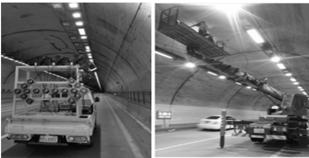
그림 1. 터널 라이닝 촬영과 터널 균열 보수 Fig. 1. Imaging of tunnel linings and crack repair.
