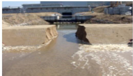
(d) Scour surface expanded by tractive force
