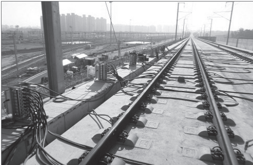
[그림 1] 궤도/노반 인터페이스 복원 (PRCG공법)
