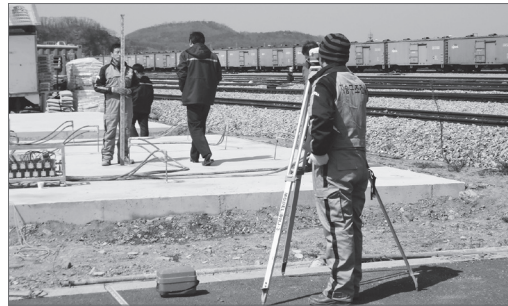
② 레벨계 설치
