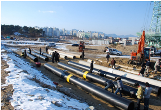
Fig. 4. PE pipe testbed site
