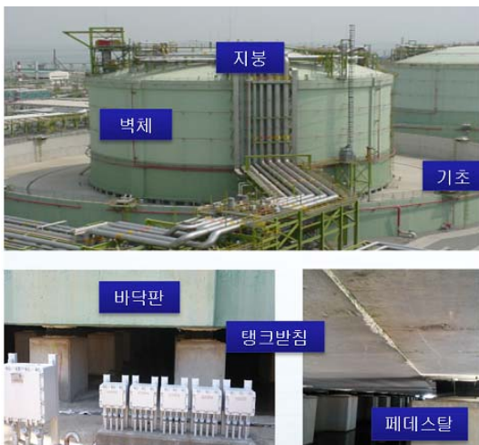
Fig. 1. Form of LNG Storage Tanks.
