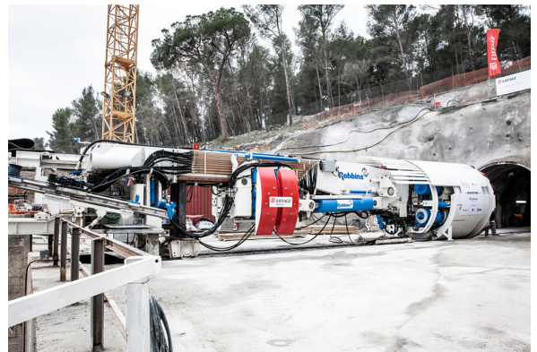
〈그림 1〉 여덟 번째 사용된, 동일 Robbins 재활용 TBM
