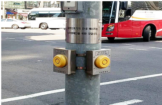
그림 2. 신호등 전주에 이중으로 설치된 음향 신호기 수동 조작 버튼 Fig. 2. Signal lamp with two sound signal generator's operating button
