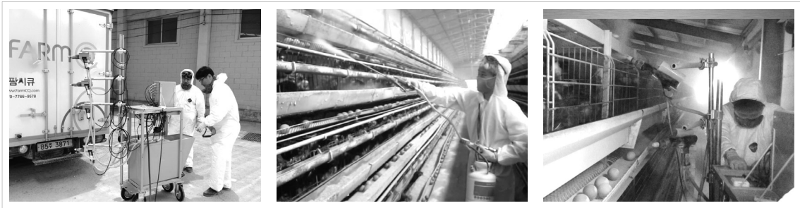
▲ 실리카 시공 모습
