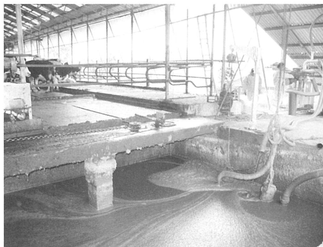
▲ 축사 내 스크레퍼를 통해 끌어온 분뇨를 흡입하여 고형분(퇴비)과 액비로 분리하여 보낸
